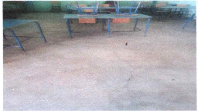
Foto 4: Sustrucion de piso ceramico para dos aulas del primer nivel
