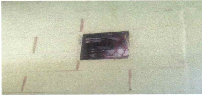
Foto 1: Sustrucion de flipones, para la planta baja del establecimiento
