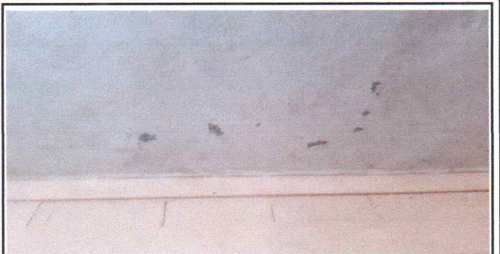
Foto 6: Cernido en muro, para dos aulas del primer nivel
