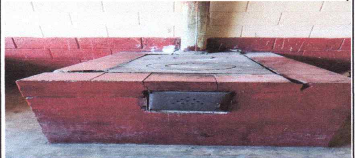
Foto 2: Sustrucion de estufa rural completa, para la cocina del establecimiento
